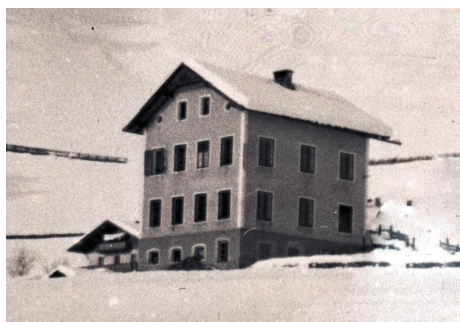
Das alte Schulhaus unterhalb vom Schiener, das 1980 glücklicherweise dem Neuen wich.
